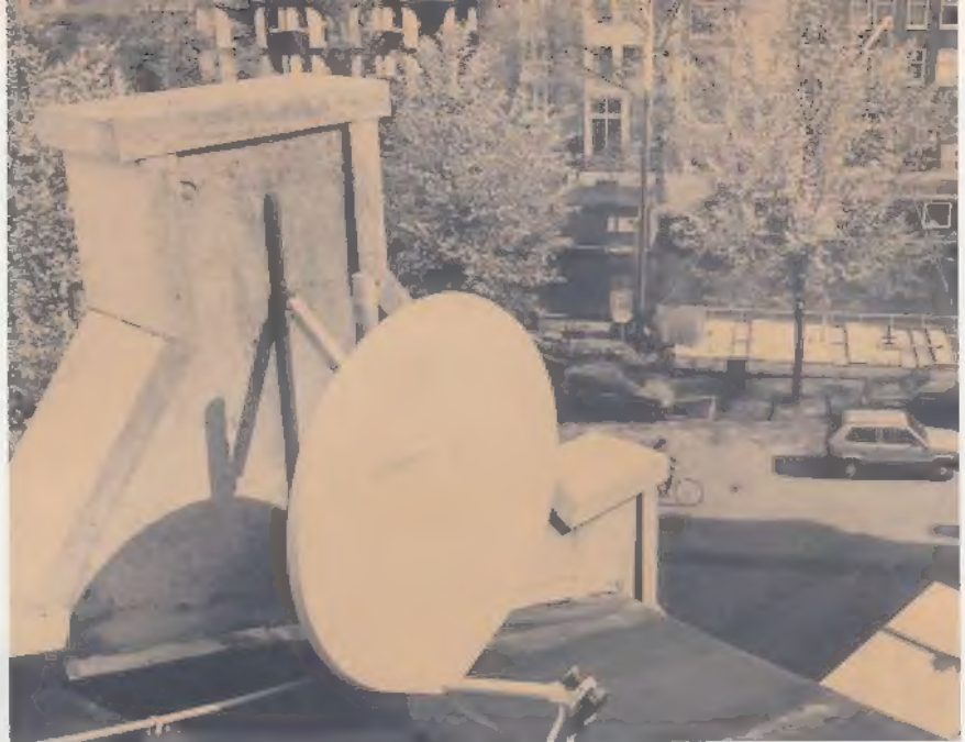
Schotelantenne weggewerkt achter de gevel ontsiert grachtenpand niet.
